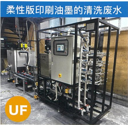
柔性版印刷油墨的清洗废水 摆脱药剂处理, 实现省人化 (采用自动运转, 无需安排专员调整药剂)
